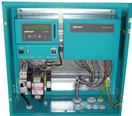
Figura 7: Installazione del misuratore RIPRESS smart nel quadro di campo
