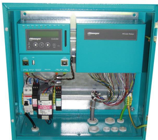
Figura 11: Installazione del misuratore RIPRESS premium nel quadro di campo
